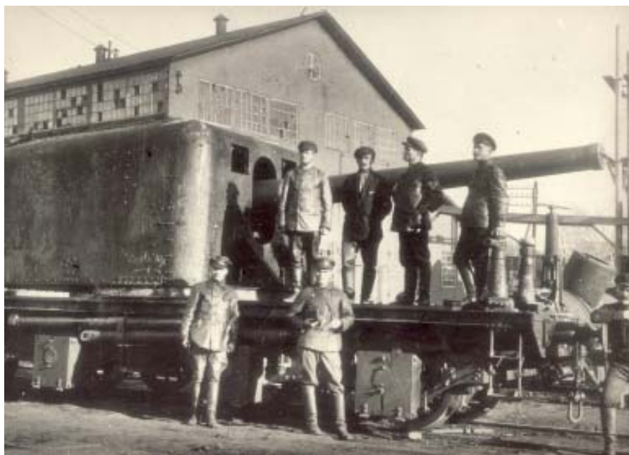
Изготовленные на заводе пушки устанавливали на железнодорожные платформы
