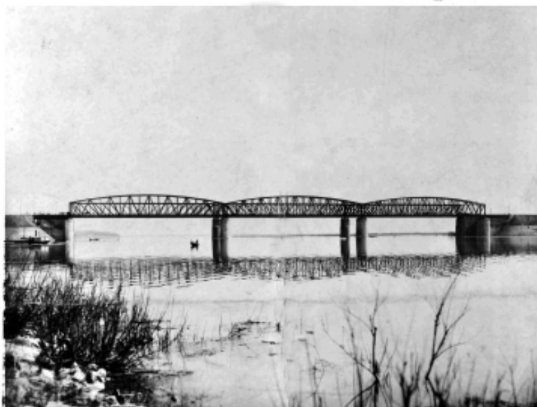
Мост под один путь через р. Самару—3 пролета по 40 саженей,—общей длины 140 саженей. Изготовлен и установлен Сорвонской заводом в 1905 году. Обход всех мостов 204 340 руб.
