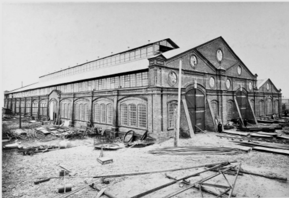
Котельная судостроительного отдела. Первый вид.
