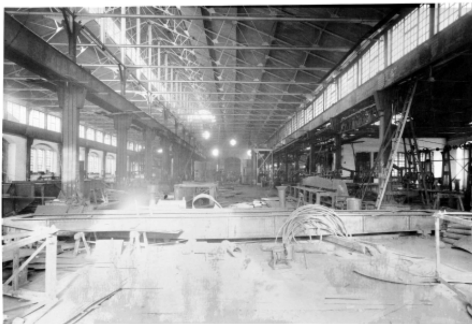
Котельная судостроительного отдела. Верхний этаж
