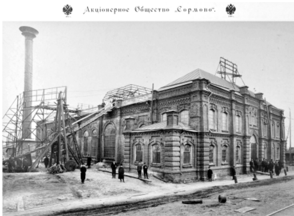
Центральная электрическая станція. Первый вид.
