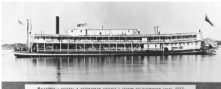
„Муромец“ — пароход в деревянном корпусе с задним расположением кают. 1905.
