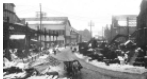
УЧАСТКИ ЗАВОДА До и после реконструкции
