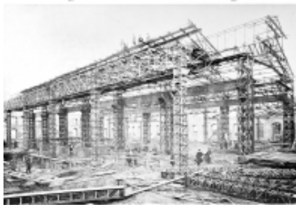
Строительство здания фабрики. 1890 г.
