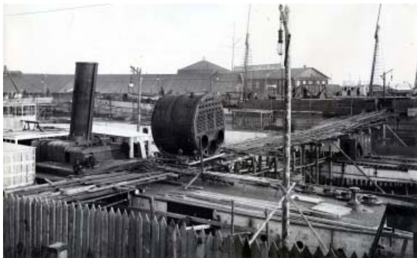
1903 год. Погрузка котла на шхуну «Слава». На столбах висят «свечи Яблочкова», которыми освещалась территория гавани
