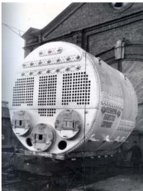
У 2-го Котельного цеха котел погружен на ж.-д. платформу. Слева - видна стена Мостового цеха.
