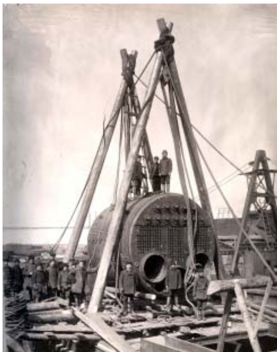
1903 год. Погрузка котла на шхуну «Слава». На столбах висят «свечи Яблочкова», которыми освещалась территория гавани
