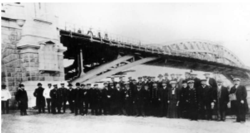
Мост через Москва-реку
