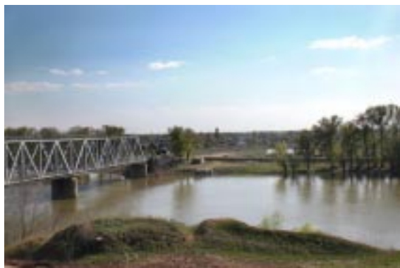
Мост через р. Ахтуба
