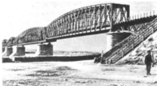
Мост через р. Обь
