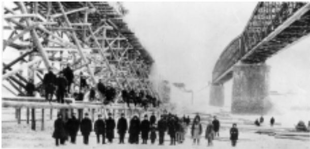
Подмости (слева), на которых собирались пролеты моста.
