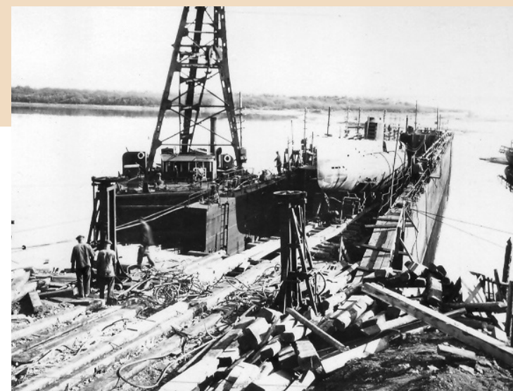
Погрузка ПЛ в док для транспортировки. 1930-е
