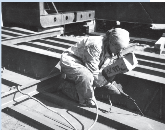
Электросварка набора корпуса
