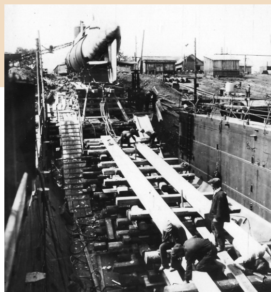
Погрузка ПЛ в док для транспортировки. 1930-е
